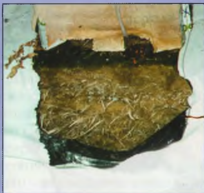
ФОТО 80. ПОВРЕЖДЕНИЕ КОРНЕВОЙ СИСТЕМЫ ПРИ ВЫСОКОМ ЕС СУБСТРАТА (ВЫШЕ 8).
