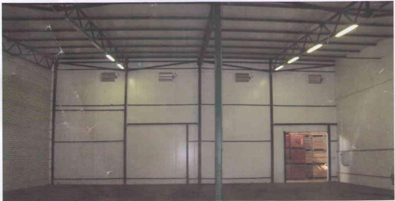
Вид камеры смешения, получившейся из напорной и наружной стены:
