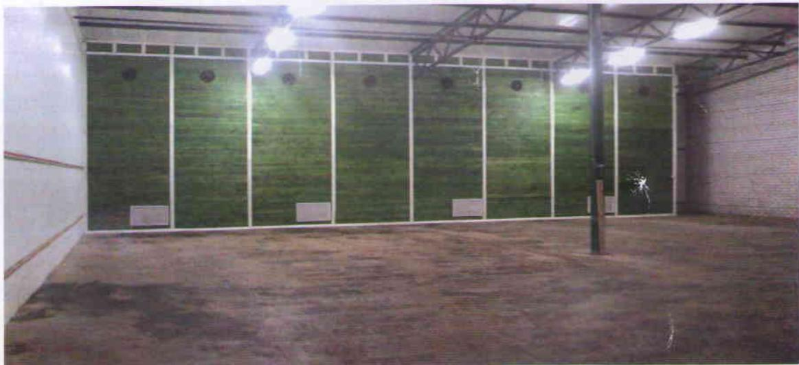
Изображена напорная стена, создающая смесительную камеру. Внизу стены установлены рециркуляционные заслонки, защищённые решётками. Сверху врезаны вентиляторы каналов.
