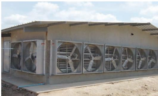
Для достижения оптимального негативного давления необходимо создать правильное соотношение количества открытых приточных форточек и работающих вытяжных вентиляторов. Это обеспечивается при помощи механического управления системой. Уровень негативного давления может измеряться при помощи ручного или настенного манометра.
