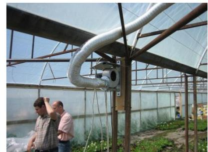
Благодаря тому, что воздух между слоями пленки ограничивает ее подвижность, нет необходимости натягивать проволоочные опоры для пленки вдоль теплицы. К тому же это повышает светопроницаемость и снижает трудозатраты на строительство теплицы.
