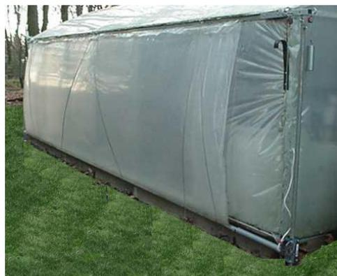
РИС. 2. СВОРАЧИВАЮЩАЯСЯ ШТОРА, НАДУТАЯ ВОЗДУХОМ, В ЗАКРЫТОМ ПОЛОЖЕНИИ
