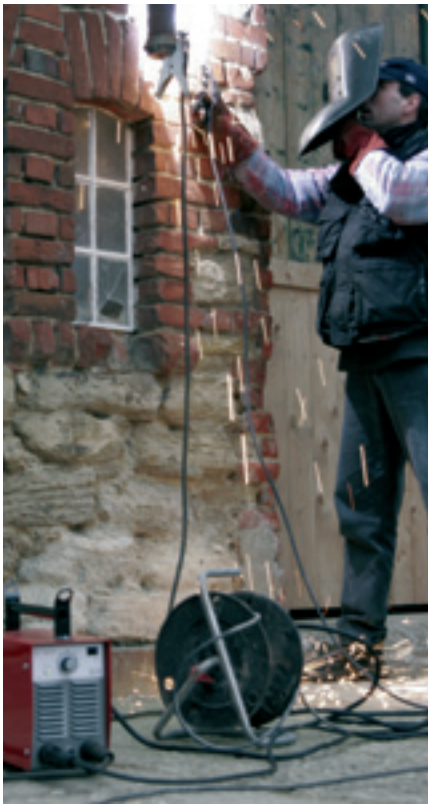
Лучшее решение для ремонтных работ: инвертор позволяет использовать электроды диаметром 3,2 мм на 230 В.
