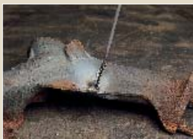
Должным образом выровненные компоненты привариваются друг к другу в двух точках, расположенных с противоположных сторон детали.
